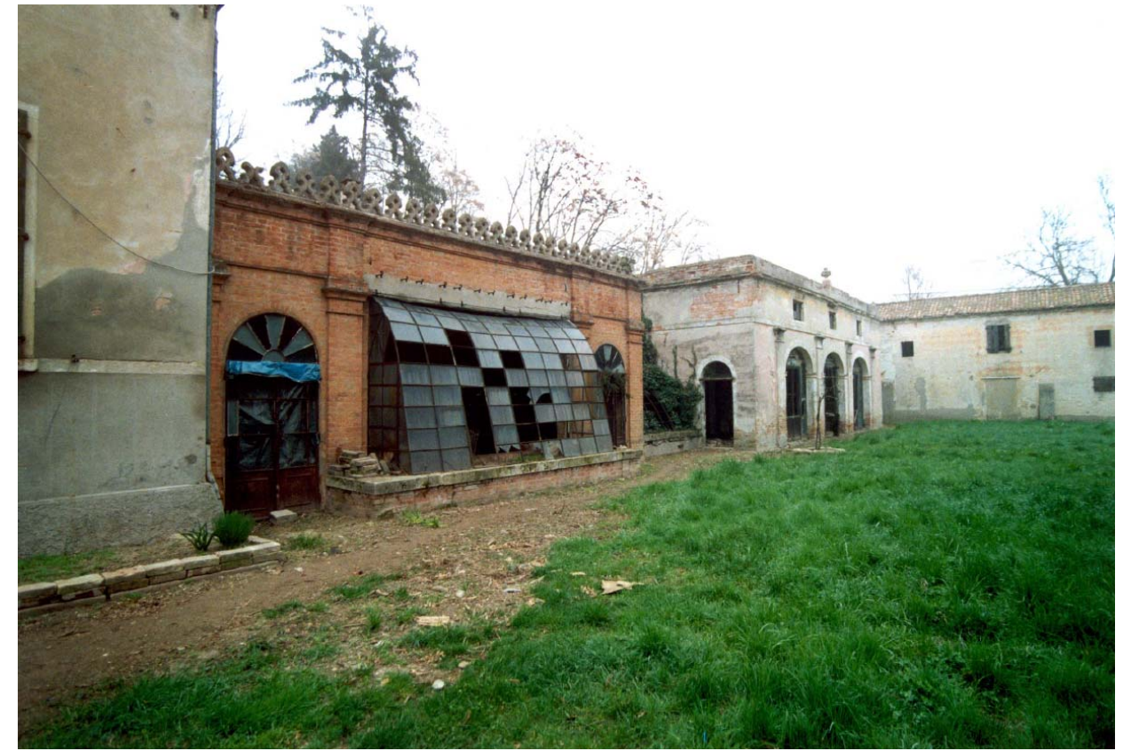
Foto 3: vista delle serre del giardino nord
